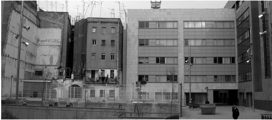
Imatge que mostra el contrast entre la flamant nova facultat i l'edifici afectat
