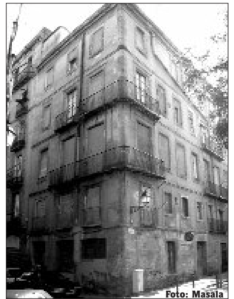
Edificio vacío y tapiado por el Ayuntamiento en Bases de Sant Pere 3
